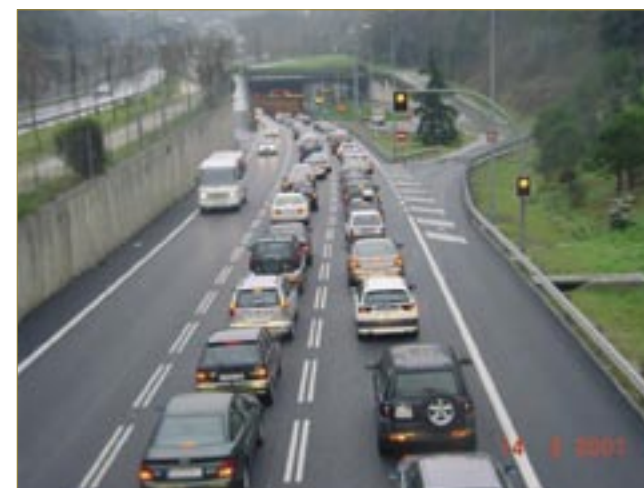
Utilisation alternative d'une voie centrale, dans un sens de circulation, puis dans l'autre sens, pour un tunnel urbain avec un fort trafic pendulaire
