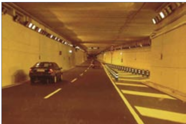
Illustration d'une situation à éviter : une bretelle d'entrée à l'intérieur d'un tunnel
